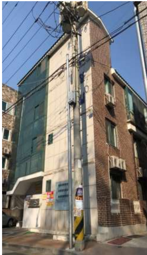
오래된 건물의 앞면만 대리석과 유리로 치장
