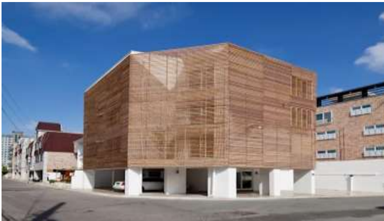
각파이프 루버로 디자인한 건물 외관
