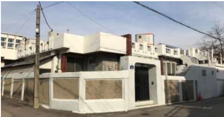
1~2층 단독 주택은 리모델링 시 주차장을 추가 확보해야 함
